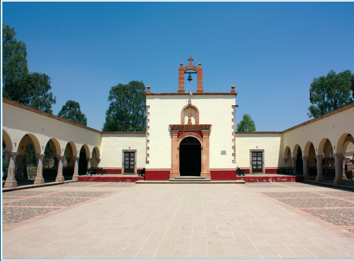
◀ Figura 4. Construcción actual de la capilla de San Juan Bautista, Lomas de Bracho, Zacatecas (Fotografía: Diana Ugalde Romo 2012).
