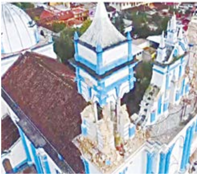
FIGURA 11. Daños en Santa Lucía debido al sismo del 7 de septiembre de 2017 (Fotografía: Figueroa Esquinca, 2017)
