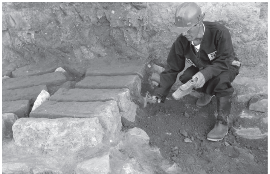
FIGURA 3. Un trabajador fabrica adobes para la rehabilitación de la iglesia de Santa Clara, Pomacocha, Perú (Fotografía cortesía: A-RSF).
