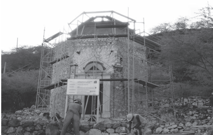
FIGURA 4. Proceso de rehabilitación de la capilla de Trindade, Isla de Santiago, Cabo Verde (Fotografía cortesía: A-RSF).
