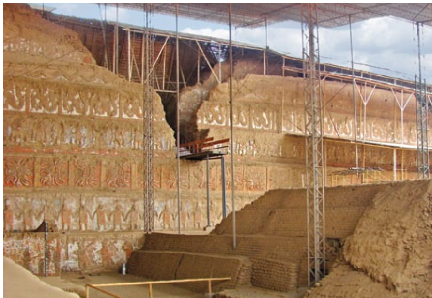
FIGURA 2. Continúa la delicada consolidación y restauración de los frágiles murales policromos, protegidos por un techo. Huaca de la Luna, Perú (Fotografía cortesía: WMF, 2010). FIGURE 2. Delicate consolidation and restoration of the pyramid's fragile polychrome murals continues beneath a protective roof. Huaca de la Luna, Peru (Photography courtesy: WMF, 2010).
