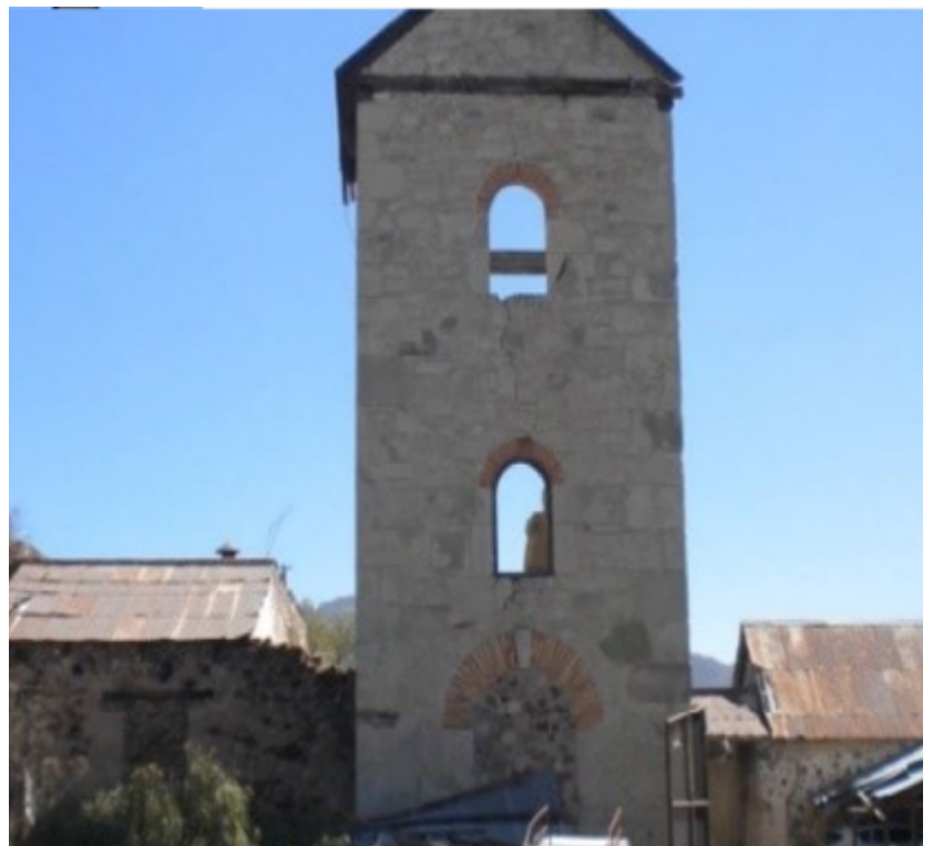
FIGURA 6. Mina La Corteza. Estado actual (Fuente: Hidalgo Tierra Mágica, A. C., 2021).
