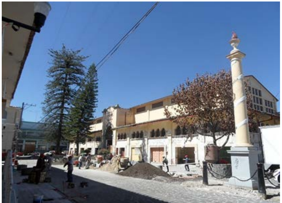
FIGURA 3. Proceso de las obras de recuperación de la plaza Alcalde y García, 2000, en el barrio de San José (Fotografía: Polimnia Zacarías, 2010).
