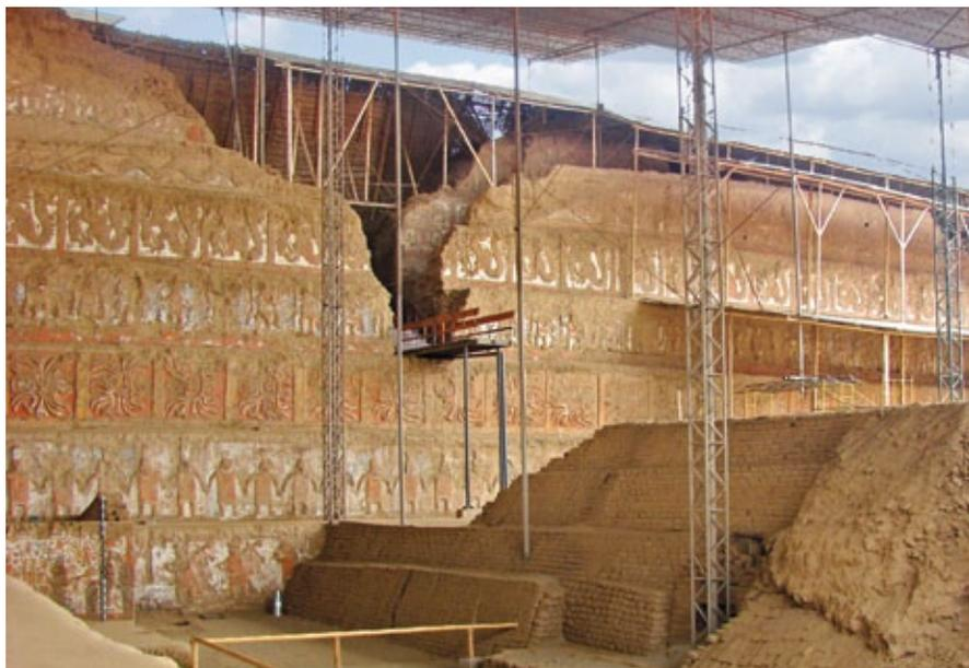
FIGURA 2. Continúa la delicada consolidación y restauración de los frágiles murales policromos, protegidos por un techo. Huaca de la Luna, Perú (Fotografía cortesía: WMF, 2010).
