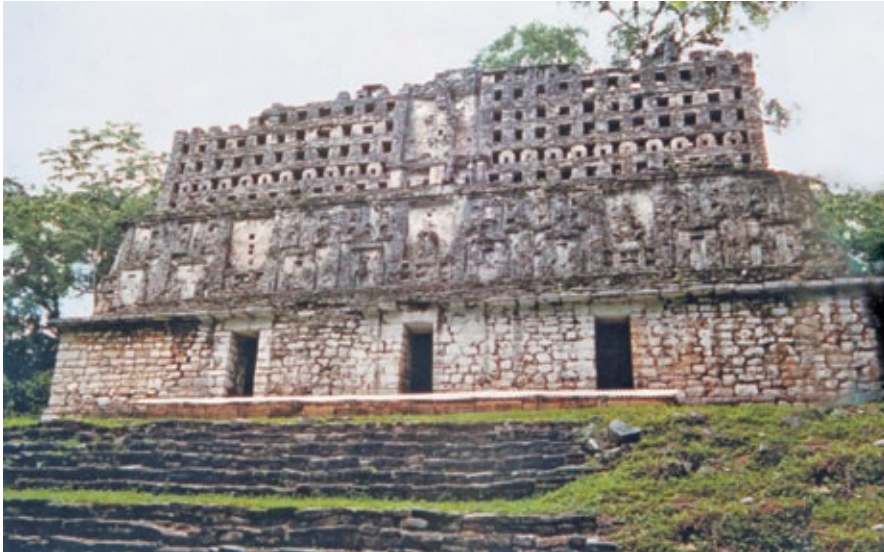
FIGURA 1. Vista frontal del Edificio 33 (Fotografía cortesía: INAH).
