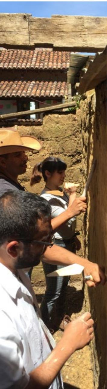
nes, grietas o fisuras pueden ser rellenados con suelos reciclados o compensados para que se vuelvan similares a los originales, pero siempre cuidando su aplicación gradual.
