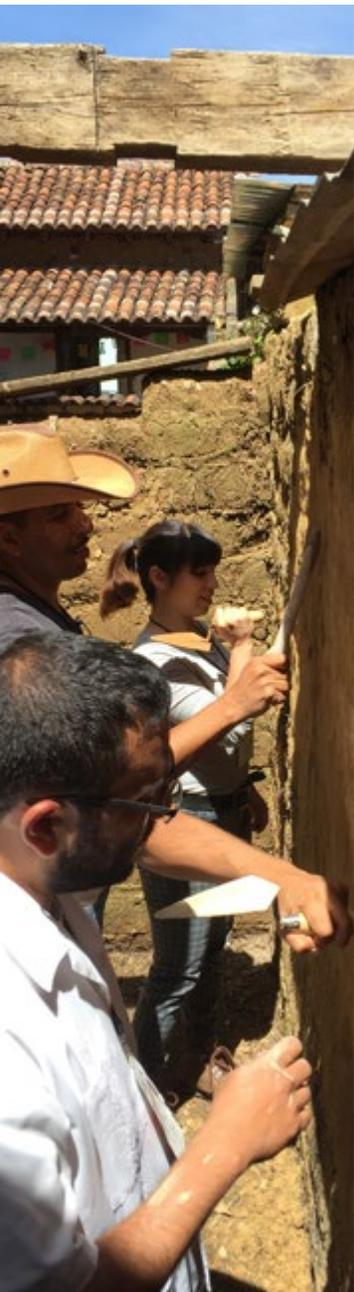
estado líquido; con 25% tendrá una condición plástica que, si bien le permite fluir, será capaz de conservar su forma si se coloca en un molde. Sin embargo, si se intentara compactar dentro de éste, no se conseguiría densificarla, por ser demasiado dúctil.
