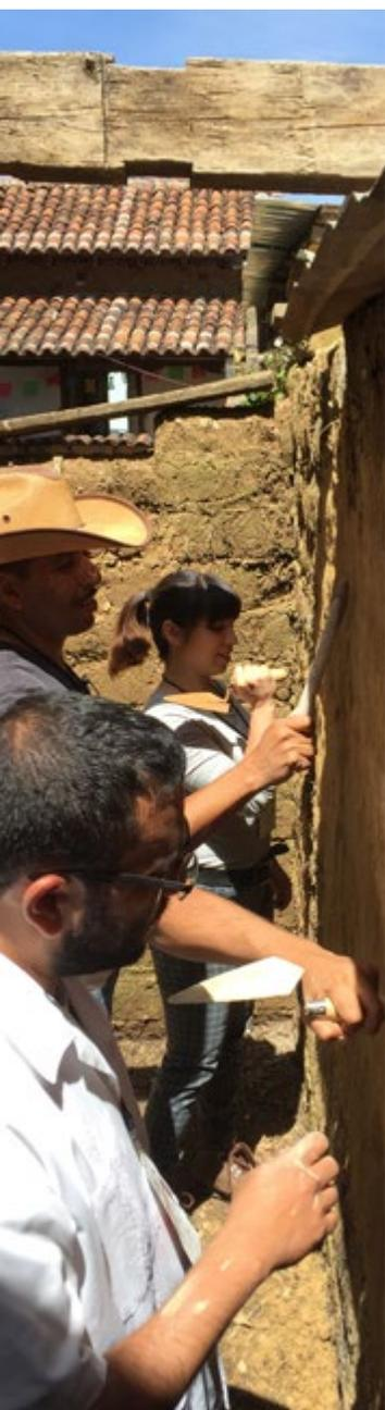
FIGURA 8. Los muros arqueológicos del sitio de Bellavista, en Lima, Perú, daban la falsa impresión de haber sido construidos con la técnica de tapia, pero sus patrones de deterioro evidencian el uso de tierra amasada en estado plástico (Fotografía: Luis Fernando Guerrero Baca, 2017).
