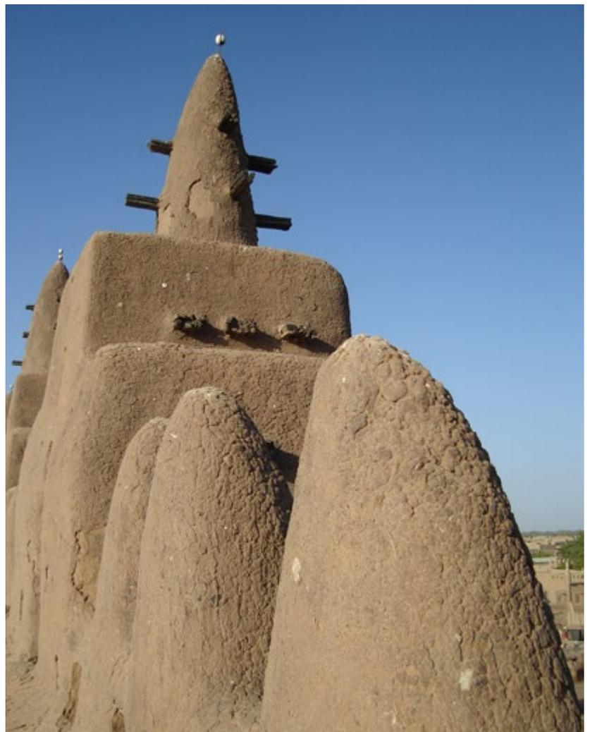
poderse aplicar, al endurecer seguramente tendrá problemas de retracción y agrietamiento. Para enfrentar esa condición, debe aplicarse en capas delgadas. En cambio, para hacer adobes se utiliza un material menos plástico que, además de requerir menor cantidad de agua, debe poder verse en moldes o gaveras y desmoldarse rápidamente, conservando su forma y volumen.
