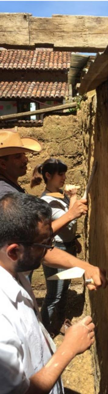
FIGURA 12. Práctica de consolidación y reenterramiento usando tierra modelada en las clases de la Maestría en Conservación y Restauración de Bienes Culturales Inmuebles de la ENCRYM-INAH (Fotografía: Luis Fernando Guerrero Baca, 2019).
