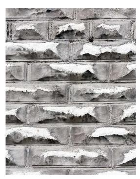
FIGURA 2. Dos tipos de tabique de cemento (20 x 10 x 6 cm). Izquierda, detalle del aparejo del tabique liso con bisel; derecha, detalle del aparejo de tabique grotesco con bisel (Fotografías: Alejandro Leal y Alberto Muciño, 2020; fuente: colección de los autores).
